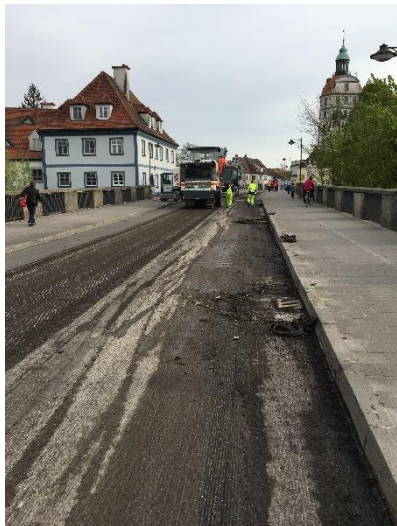
Abgefräste Oberfläche
